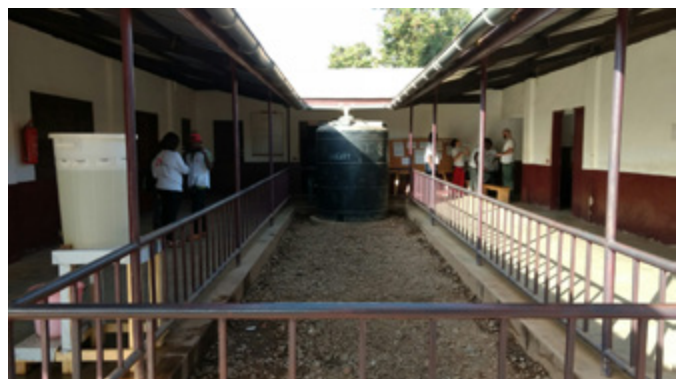
Ein neu errichteter Tank sammelt Regenwasser. Da Wasser in Bossangoa knapp ist, wird es zum Teil gereinigt und als Trinkwasser verwendet. © MSF
